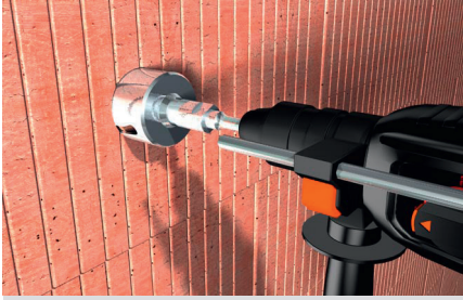
Dugaljak helyének kialakítása falazatokba
