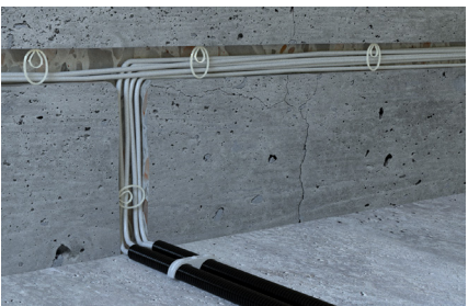
Kábelrögzítés falhoronyba < 55 mm
