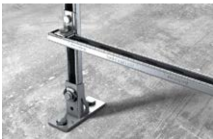
Szerelősín rögzítés padlón
