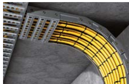
Elektromos vezetékek rögzítése
