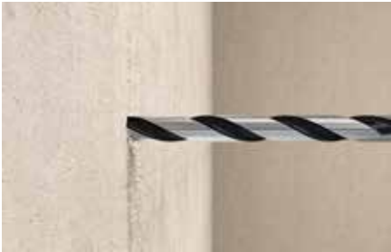
Furatkészítés betonba
