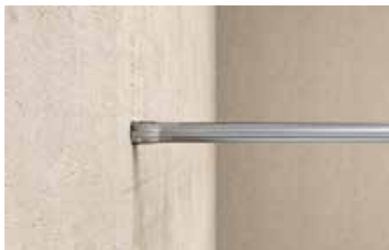
Üreges fúrás betonba
