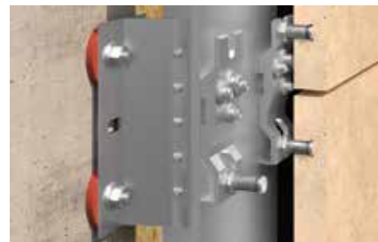
SystemOne Light homlokzati rendszer keresztmetszete terméskő panellal
