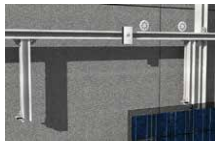
Részlet: VP 50 függőleges profil csatlakozása
