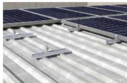
Telepítés ipari lapos tetőre Solar-P 400
